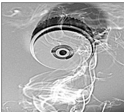
Дымовым пожарным извещателем называют устройство, которое подает сигнал, в случае возникновения очага возгорания. Термин, датчик - не является корректным по использованию к пожарному дымовому извещателю. Так, как датчик -
