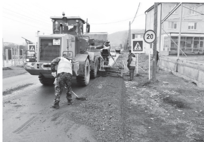
ГУП «Таштытское ДРСУ» обустроивает обочины и приступил к установке ограждений
