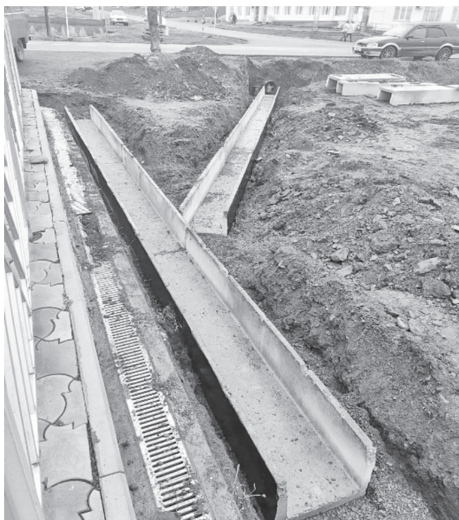
Идет укладка линейных лотков вдоль набережной
