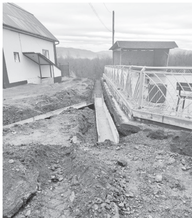
Идет укладка линейных лотков вдоль набережной
