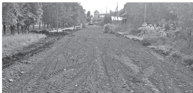
Ремонт улицы Советская продолжается. Идет отсыпка и грейдирование проездов в самом начале улицы.
