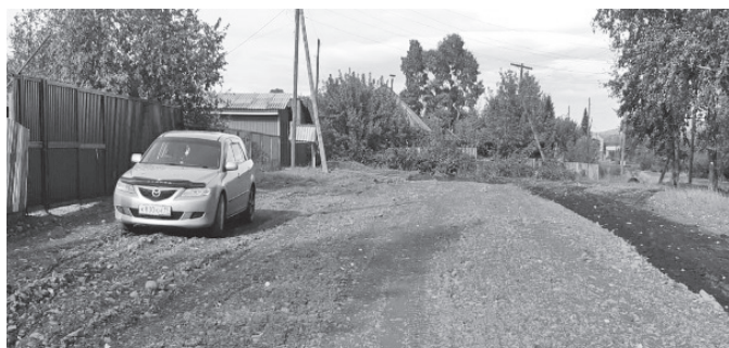
Ремонт улицы Советская продолжается. Идет отсыпка и грейдирование проездов в самом начале улицы.
