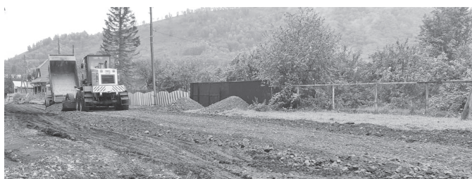
Ремонт улицы Советская продолжается. Идет отсыпка и грейдирование проездов в самом начале улицы.
