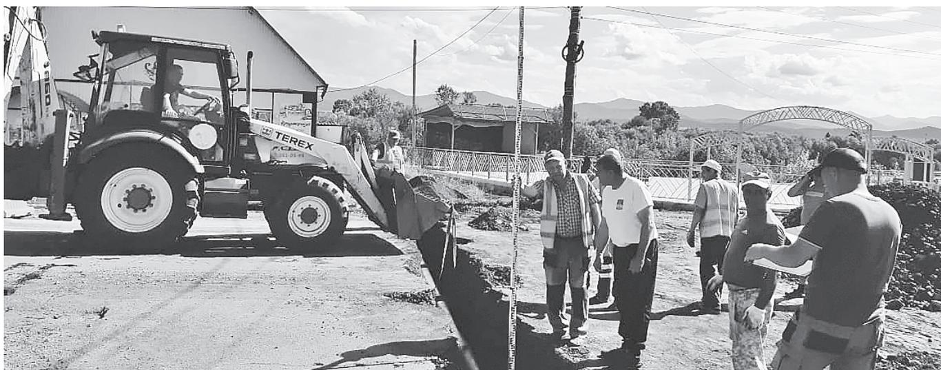
Монтаж и укладка металлических водопропускных труб – дело ответственное и не простое. Только после того, как все шесть труб будут уложены по всей длине трассы улицы Советская, проверены на прочность, тогда начнется асфальтирование дорожного полотна.
