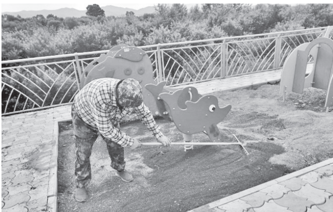
На Набережной, где установлен детский игровой комплекс для малышек готовится «подушка» для укладки мягкого покрытия
