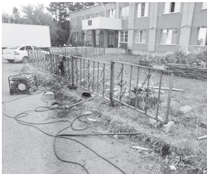
Меняется ограждение на территории, прилегающей к зданию администрации Таштыпского сельсовета
