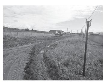
Выравнивание дорожного полотна грейдером на улицах Таштыпская и проезд Таштыпский.
