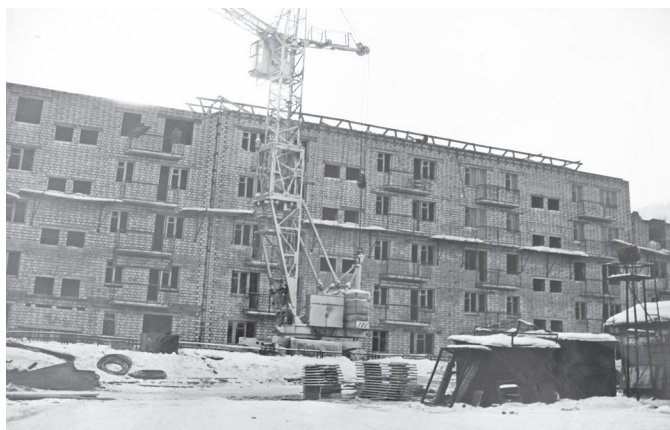
Строительство жилого пятиэтажного дома на ул. Луначарского, 1984 г.
