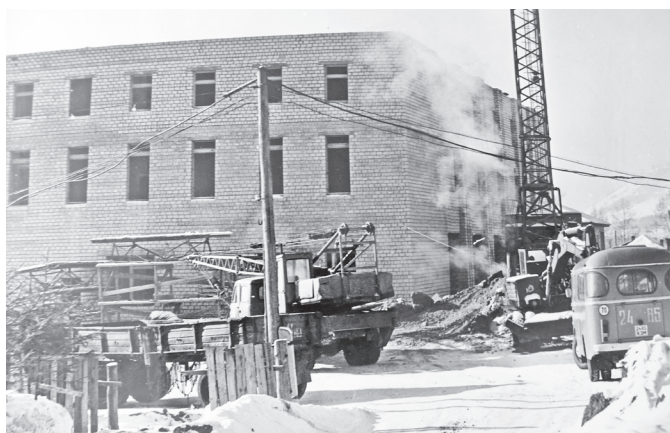
Строительство здания узла связи и Союзпечати на ул. Ленина. 1986 г.
