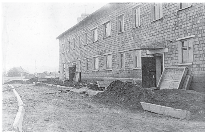
ТУСМ. Дворовая часть. Окончание строительства жилого дома на ул. Октябрьская, май 1977 года
