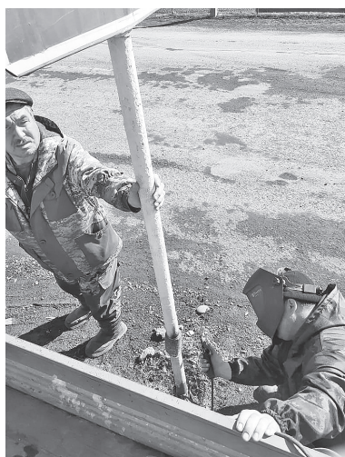
Идет ремонт дорожных знаков и уборка щебенки (подсыпки) с проезжей части дорог
